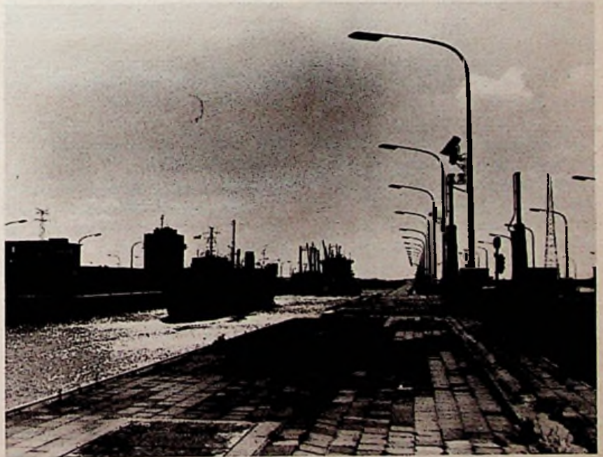
Fig. 1 Zandvliet-sluisen met radar-centrale. (Boven de boeg van het dichtst bijzijnde schip is de radarcentrale).
